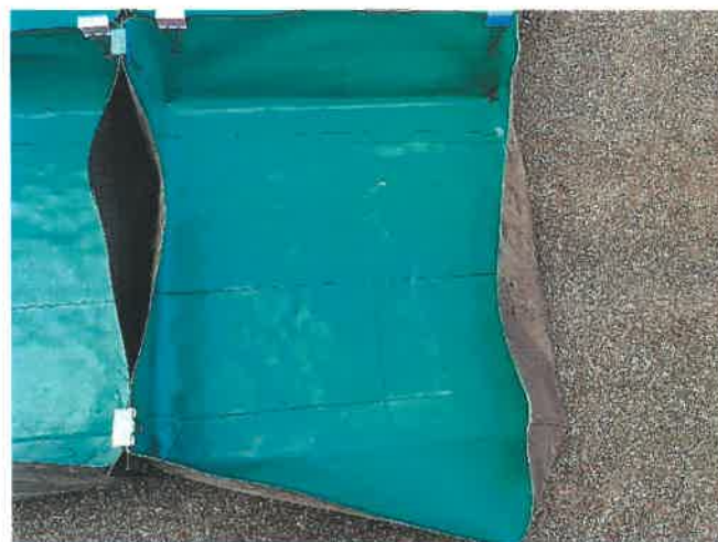
6 号试验箱 T 型缝及阴角图片
