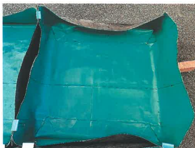
3 号试验箱 T 型缝及阴角图片
